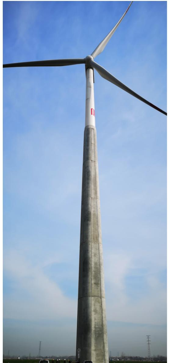
**威胜利公司 (VSL China) 建议：根据风塔的受力情况，优先选用较低张拉力，以获得良好的耐疲劳性能。**
