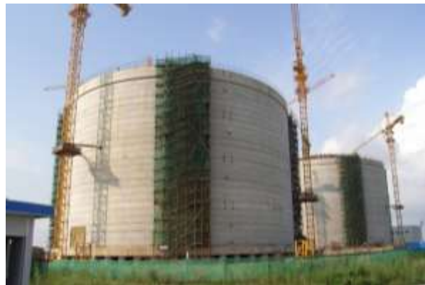
上海LNG调峰站项目 · 2008
