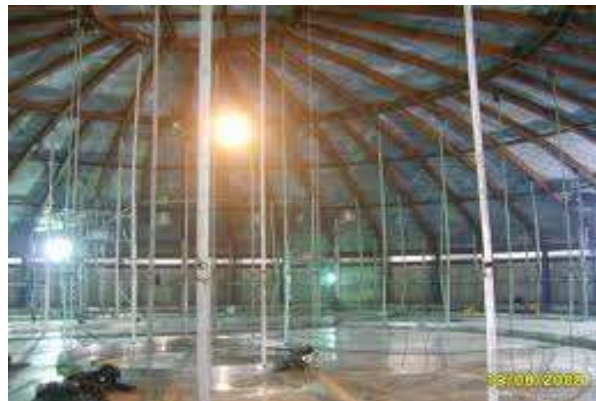
常州乙烯储罐 · 2014
