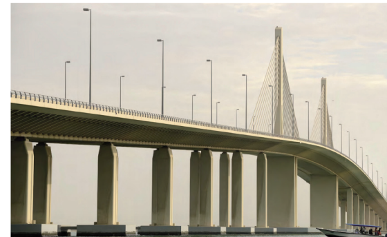
Hodariyat Bridge, 阿联酋
