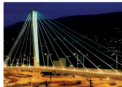
Peldar Bridge, 哥伦比亚 VSL 鞍座和监测体系
