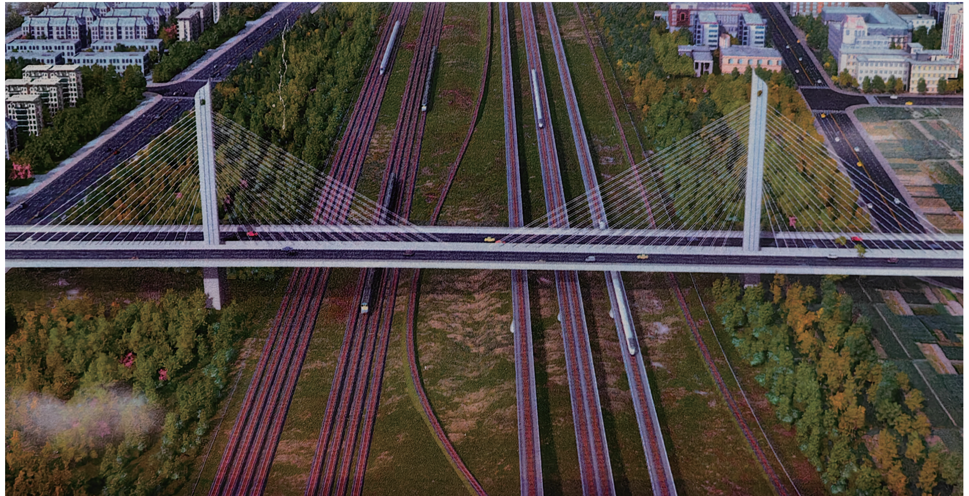
九江市新建快速路转体桥—SSI 2000斜拉索体系
