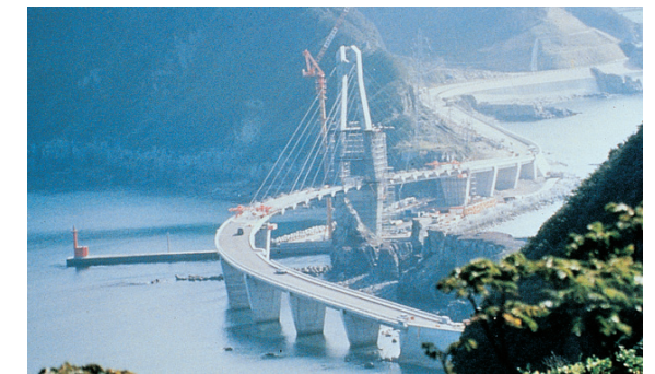
Koshiki Daimyojin Bridge, 日本
