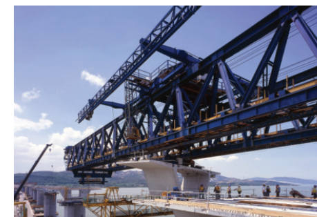
深圳西部通道——香港 架桥机施工
