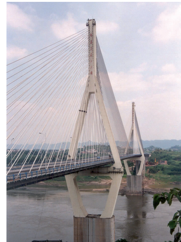
马桑溪大桥——中国重庆 (2001) SSI 2000 斜拉索体系国内首次使用
