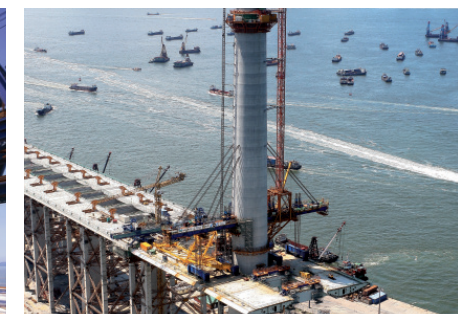
昂船洲大桥——香港 重型起吊
