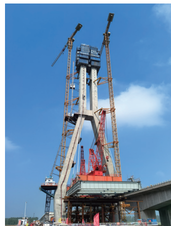
宁洛高速淮河特大桥—环氧钢绞线斜拉索体系
