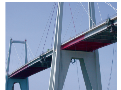
Figueira Da Foz Bridge repair, 葡萄牙 修复加固
