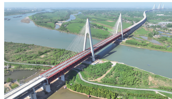
巢马铁路马鞍山长江大桥副汉桥 (2023) 全球首次使用2100Mpa高强耐候钢绞线斜拉索
